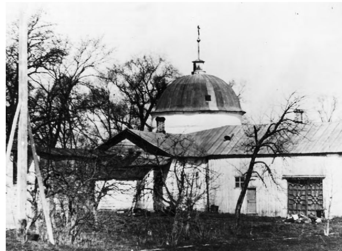
Северо-западная башня монастыря
